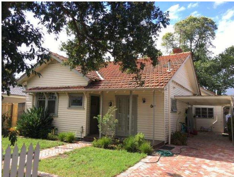
War Service Timber Homes - 1 Pareora Ave
